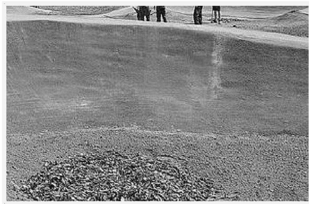
Nieprawidłowe połączenie nawierzchni jezdnej w miejscu przerwy technologicznej
