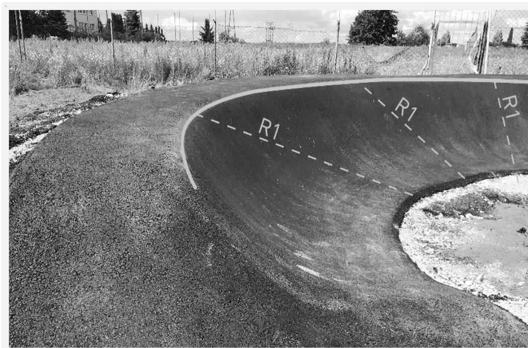
Prawidłowo wykonany zakręt profilowany – o jednostajnym promieniu zakrętu
