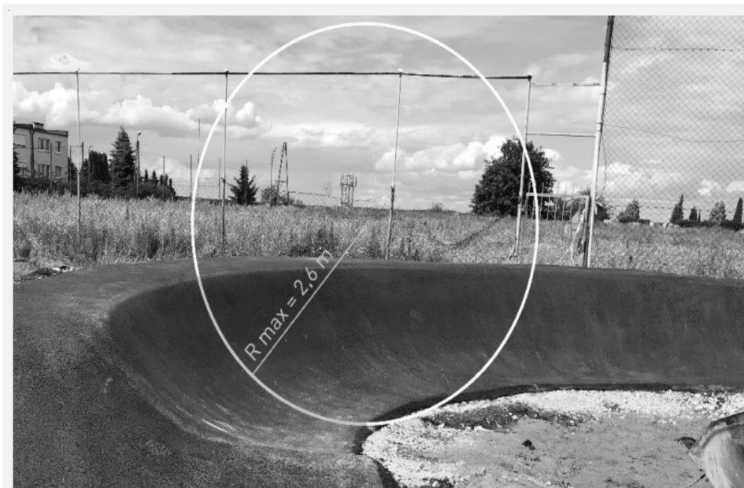
Prawidłowo wykonany zakręt profilowany, którego przekrój stanowi wycinek koła.
