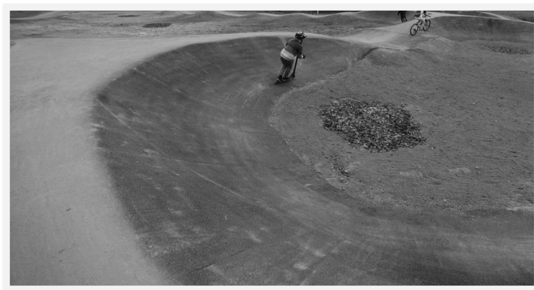
Nieprawidłowo wykonany zakręt o niejednostajnym promieniu, bez wywłaszczonej dolnej półki oraz niebędący w przekroju wycinkiem koła.
